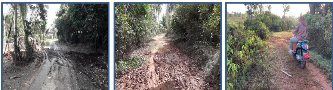
ภาพประกอบ สำรวจเส้นทางที่เกิดความเสียหายจากการเกิดอุทกภัย
