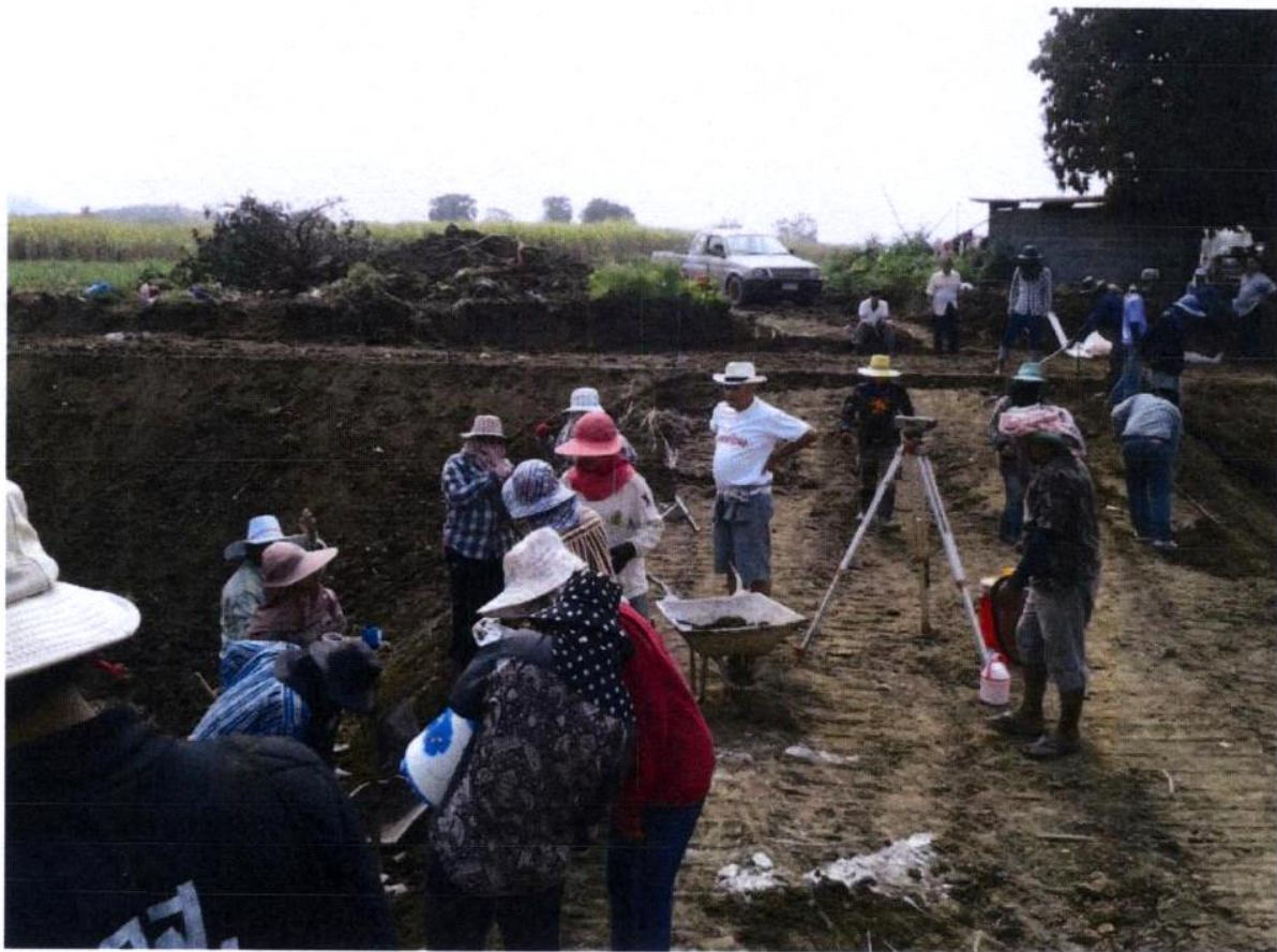
ภาพการก่อสร้างฝายน้ำล้น
