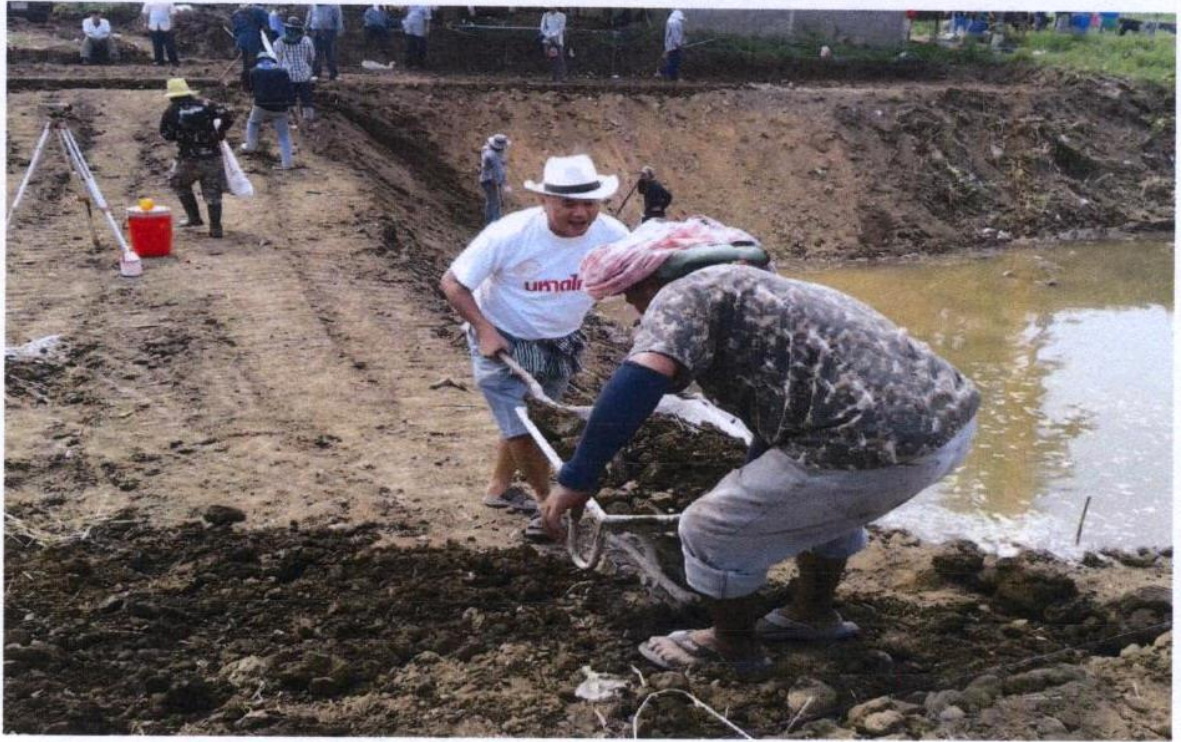
ภาพถ่ายขณะดำเนินการก่อสร้างฝายน้ำล้น
