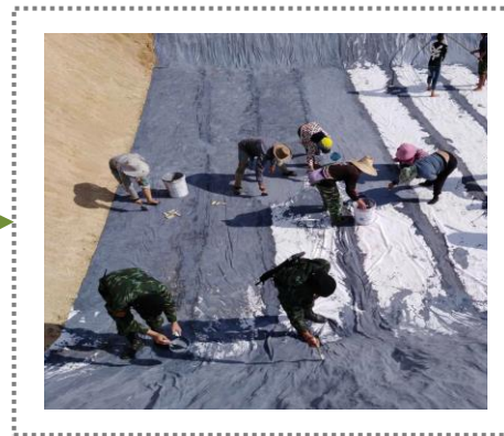
เทน้ำยางเคลือบผ้าดิบ ความหนาของบ่อน้ำ/สระน้ำ ขึ้นอยู่กับชั้นผ้าดิบ
