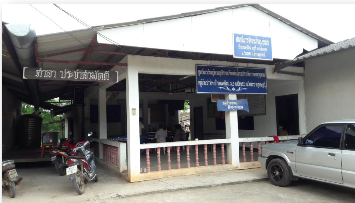
ภาพก่อนเริ่มดำเนินการก่อสร้าง
